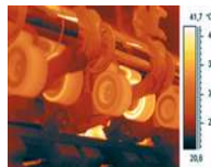
Mécanique Roulements défectueux
